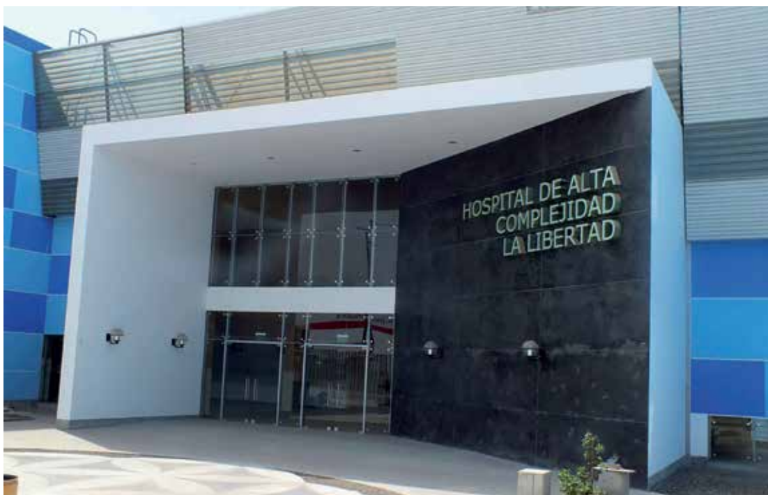
➤ Nuevo Hospital en La Libertad.
