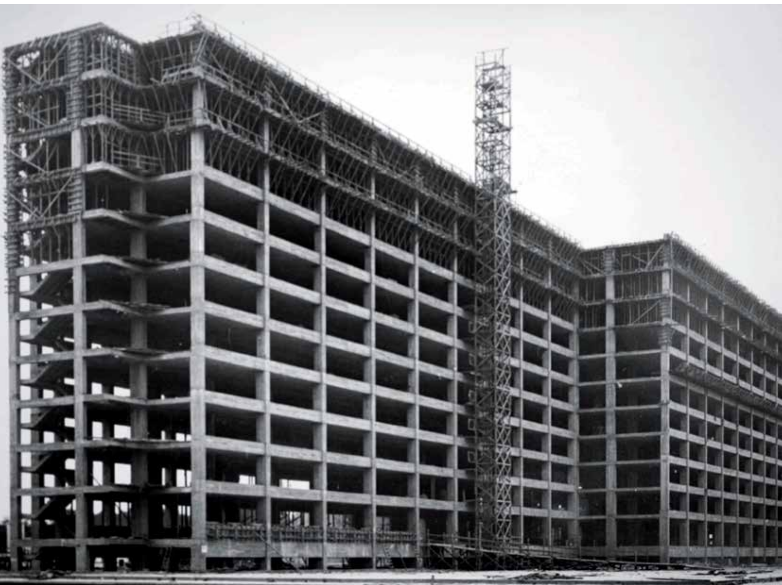
➤ Construcción del Hospital del Empleado.
