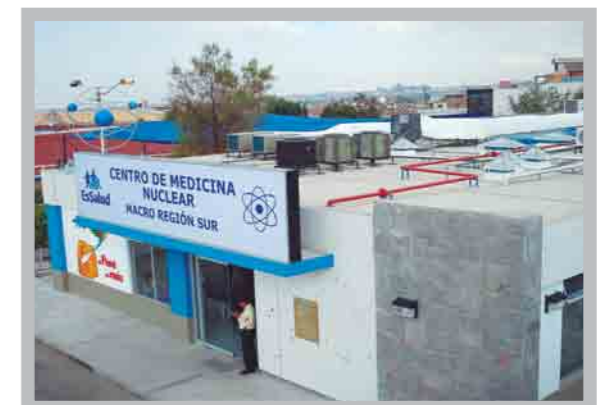
Obra finalizada del Centro de Medicina Nuclear Arequipa
