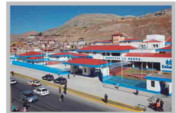
Vista Panorámica Nuevo Hospital II La Oroya - Set '09
