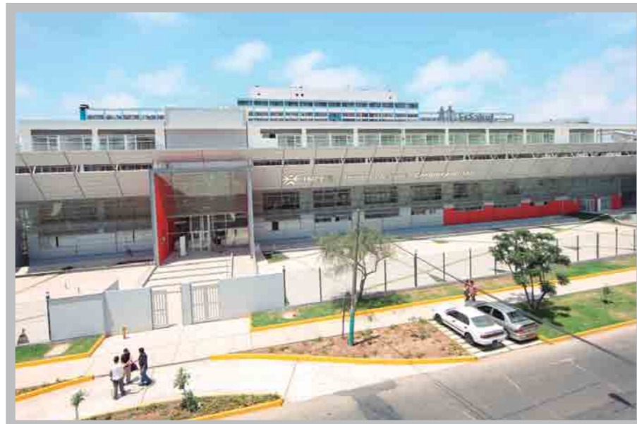
Vista panorámica nuevo Instituto Nacional del Corazón INCOR
