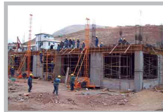
Construcción del Hospital II La Oroya
