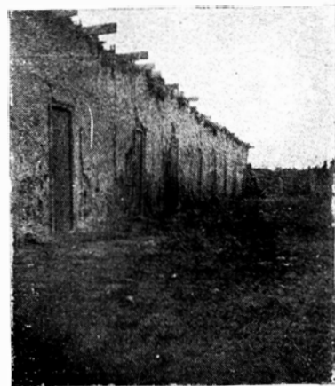
Fot. No. 6 Cañete.— Hdas.— Ranchería para personal permanente y eventual. Nótese el tronco que sostiene la pared.
