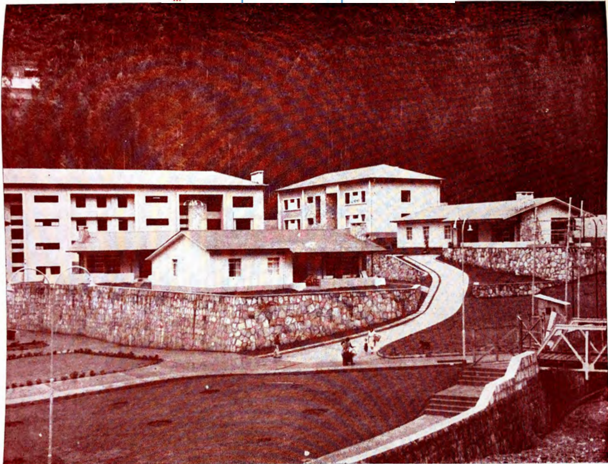
Residencias para Médicos y personal administrativo y asistencial del Hospital Obrero de Huariaca.
