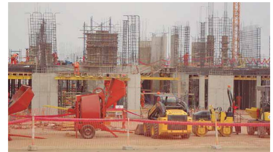
Obras del futuro hospital de Trujillo que beneficiará a 650 mil asegurados.
