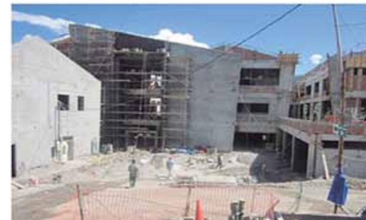
La construcción del Hospital II de Abancay se encuentra en un 60% del avance de su infraestructura.
