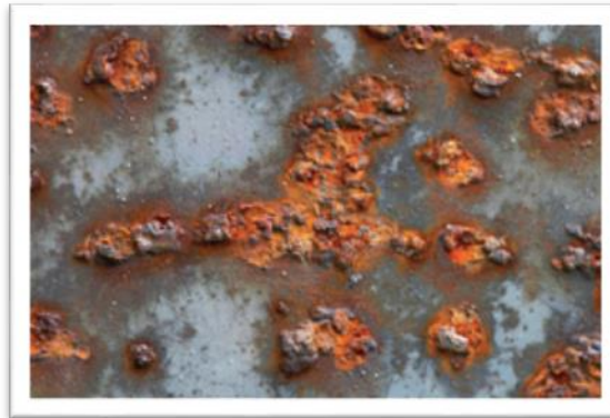
Figura 2.- Corrosión del acero inoxidable.
