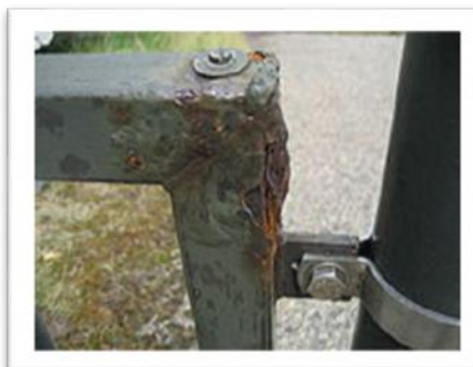
Figura 7.- Corrosión galvánica.
